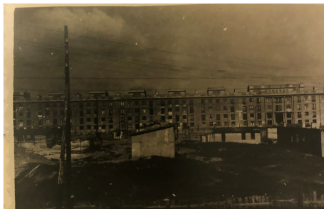
Widok budowy z ulicy Lisowskiej
